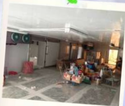
冷庫機組安裝
