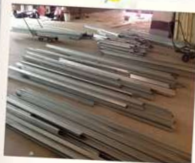
地台槽鐵預備
