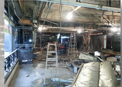
進行清拆 Demolition
